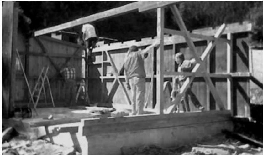
Bau der Hegehütte, 2005/06, in Saletg.
