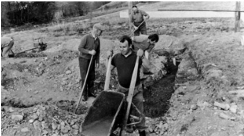
Bau des Fundaments, Ostern 1973.
